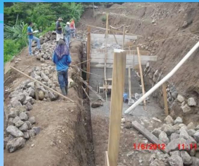
Proyecto en Ejecución, construcción de un Muro de Contención para un cancha de futbol Apoyado por el Club de apoyo San José Intibucá, Organizado por el Consulado de Honduras en Washington
